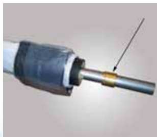
2. Hülse auf PEX-Rohr schieben, richtig drehen. Innere Anfasung muss zum Rohrende zeigen.
