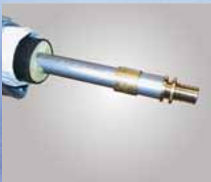
4. Fitting sofort in Rohr stecken, Rohrende beginnt sofort zu schrumpfen.
