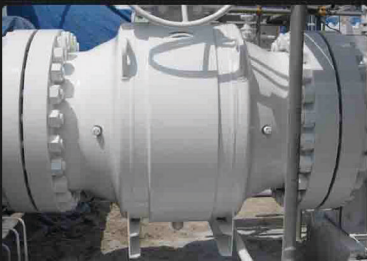
Gas pijplijn - Indonesië
