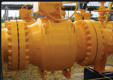
Gas pijplijn - Indonesië
