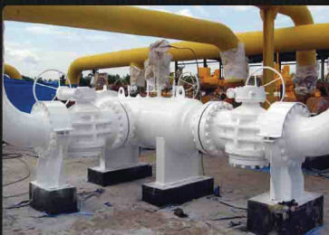
Gas pijplijn - Indonesië
