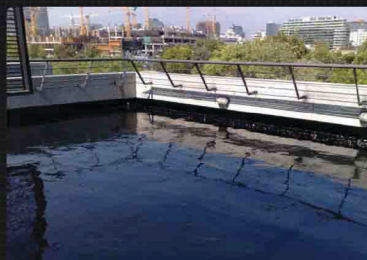
Dakterras - Chili [na]
